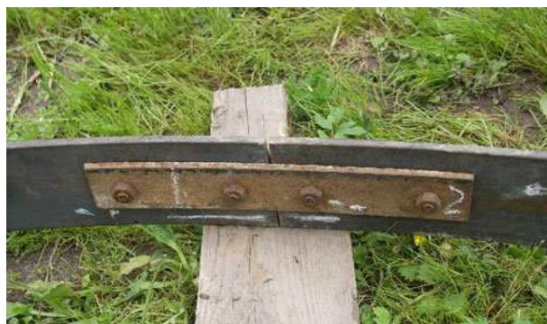
Продольное крепление дуг опорного кольца
