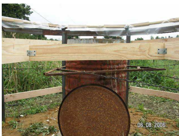
Треугольник и растяжки, выравнивающие кольцо.
