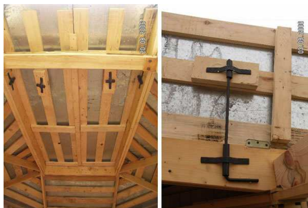
Смотровой люк изнутри и его вертикальная фиксация
