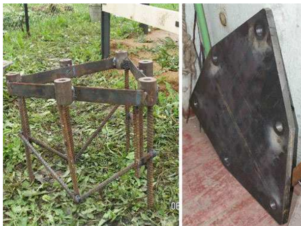
Фундамент полностью залит. Видны болты крепления для опорной пластины. Опорная пластина и крепления для неё
