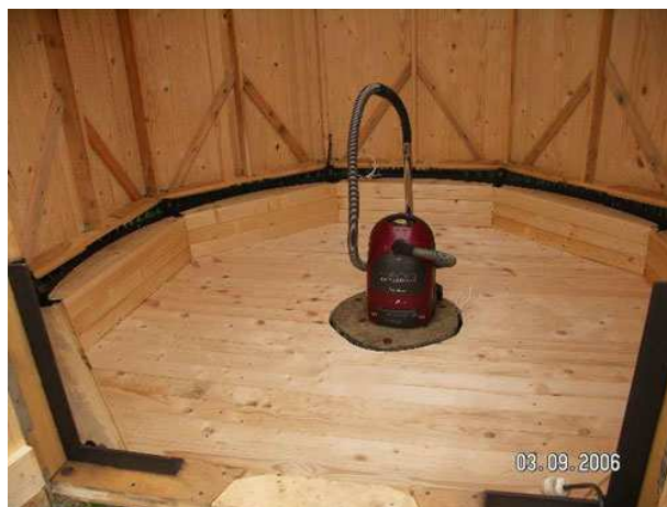
Пол обсерватории. Фундамента он не касается.
